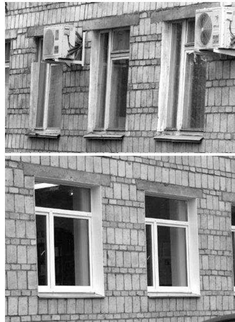
На снимке: окна корпуса №1 до и после ремонта.
