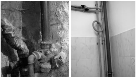
На снимке: трубы до и после ремонта.
