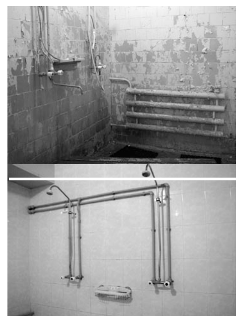
На снимке: душевые общежития №3 до и после ремонта.
