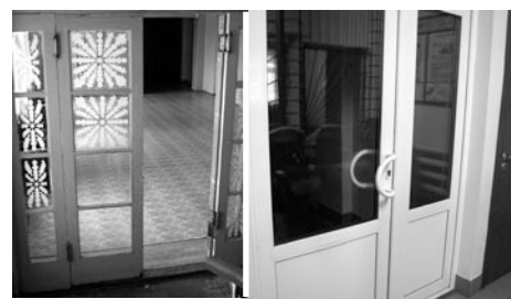
На снимке: двери до и после ремонта.
